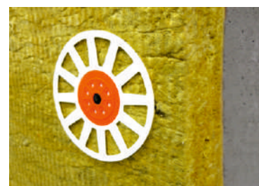
4 Isparvno instalirana termoizolaciona tipla.
