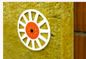
4 Ispravno instaliran termoizolaciona tipla.
