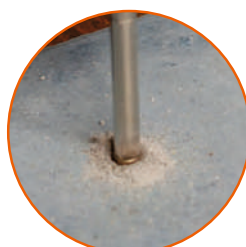
Bušenje sa blagim oscilacijama. Pažnja: Koristite vodu za hlađenje!
